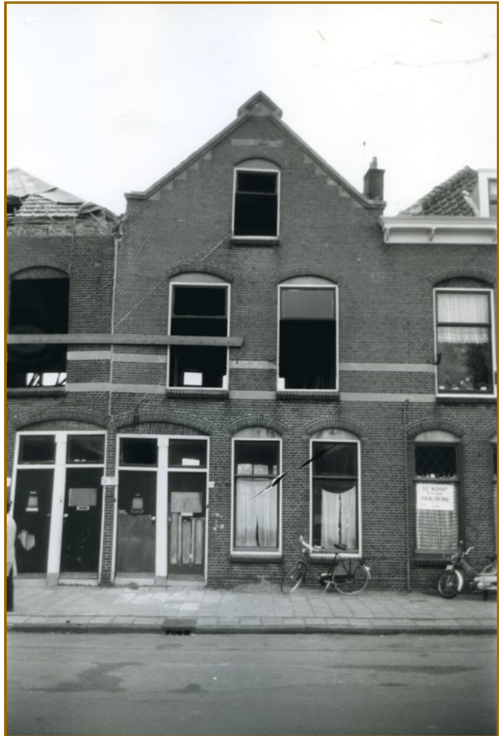
Beide panden zijn volledig afgebroken en twee nieuwe woningen zijn er voor in de plaats gekomen. De mooie doorlopende gevellijn van weleer is in dit stukje Vaart helaas blijvend verloren gegaan!
