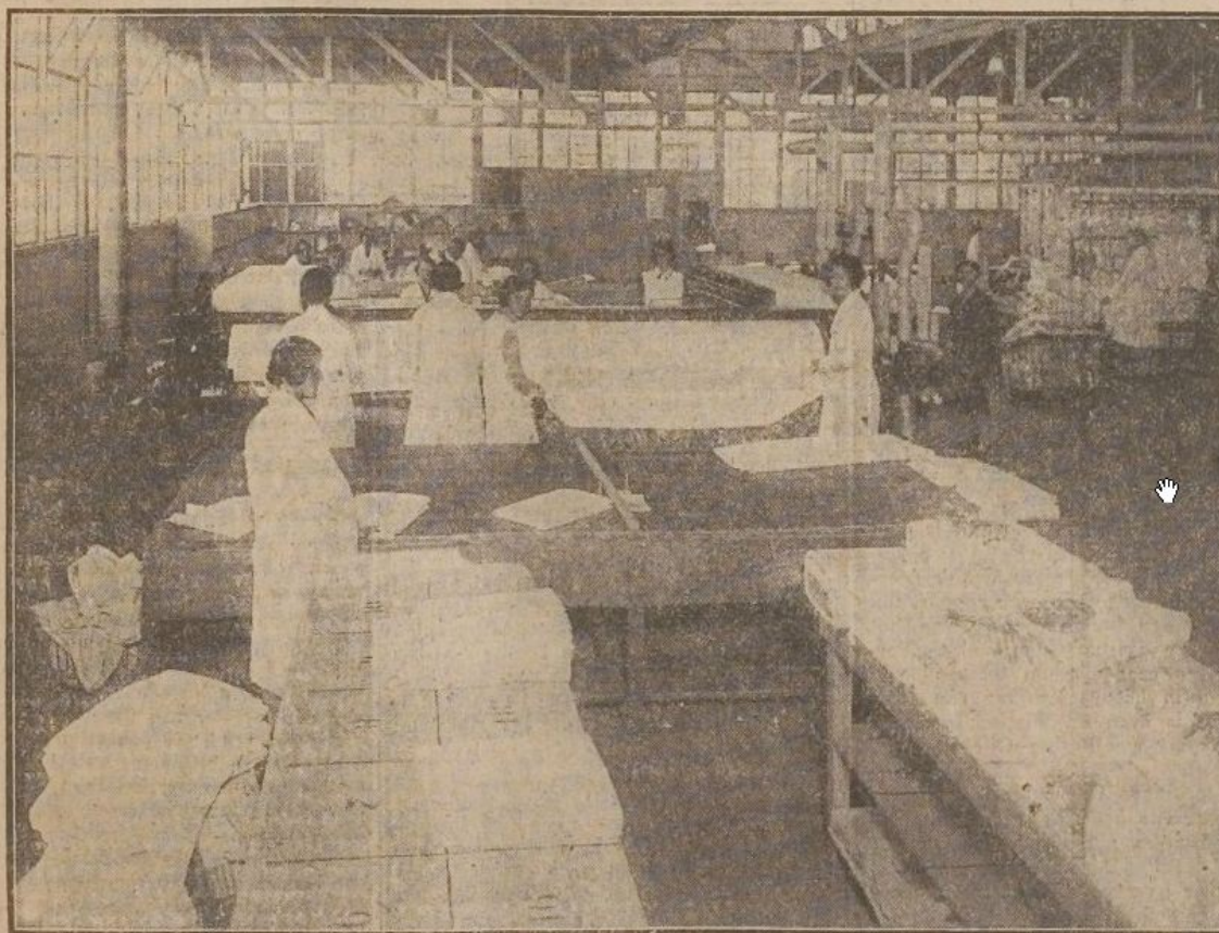
Elders in dit Blad geven wij een korte beschrijving van de gemoderniseerde Leidsche Wasscherij B. C. J. van Ommeren. Hierboven een kijkje in een hoekje dier wasscherij. Op den voorgrond de inpak-afdeling; daarachter de groote stoommangel.
