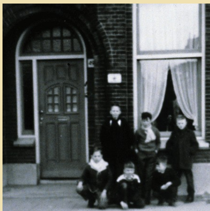
Rechts naast de voordeur het EHBO bord.
